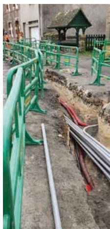
Après plusieurs semaines de travaux et la mise en place d'une déviation, les travaux de Pont d'Armes concernant l'enfouissement des réseaux sont en partie terminés. Les fourreaux étant passés, Enedis doit à présent intervenir pour passer les câbles électriques (Orange et Xp fibre de télécommunications). Nous sommes conscients que la déviation a été contraignante mais les travaux étaient indispensables et nous vous remercions tous pour votre patience !
